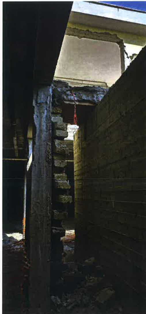
Foto 1-2 Dettaglio muratura in tufo, solaio intercapedine e muratura perimetrale
