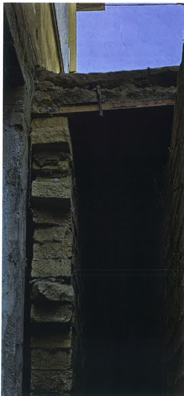
Foto 3-4 Dettaglio muratura in tufo, solaio intercapedine e muratura perimetrale
