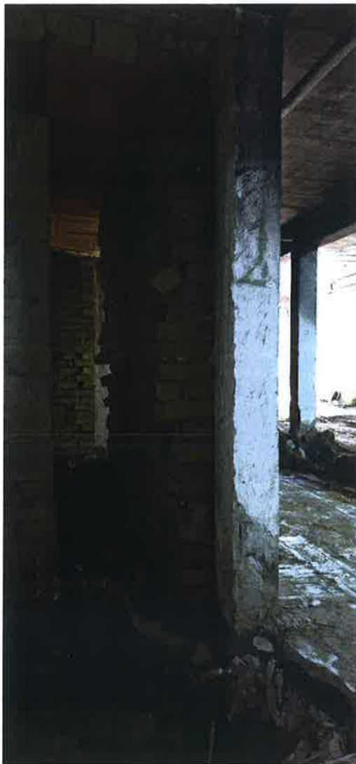
Foto 1-2 Dettaglio muratura in tufo, solaio intercapedine e muratura perimetrale
