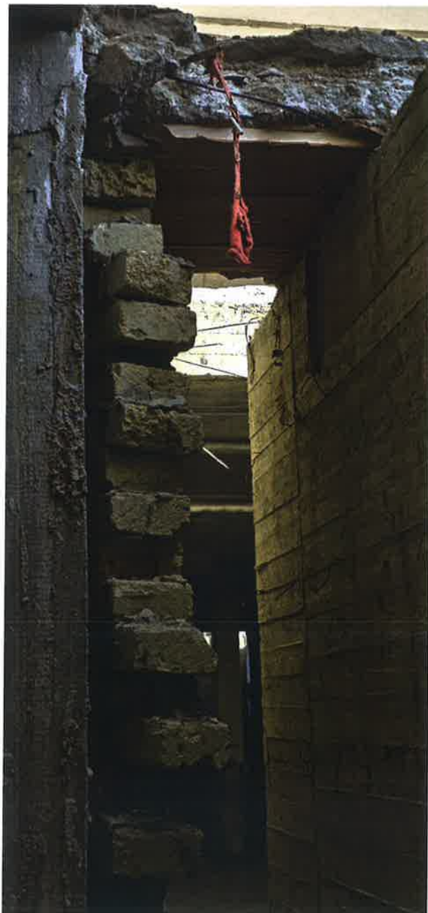
Foto 3-4 Dettaglio muratura in tufo, solaio intercapedine e muratura perimetrale
